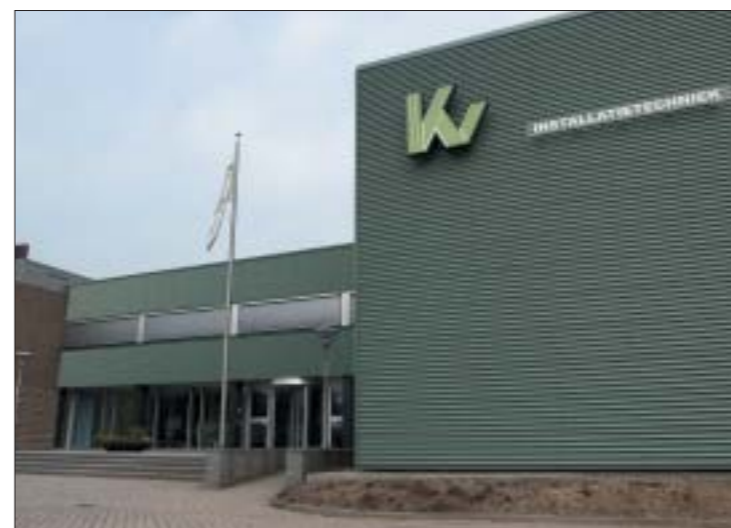
Kropman Installatietechniek in Nijmegen
