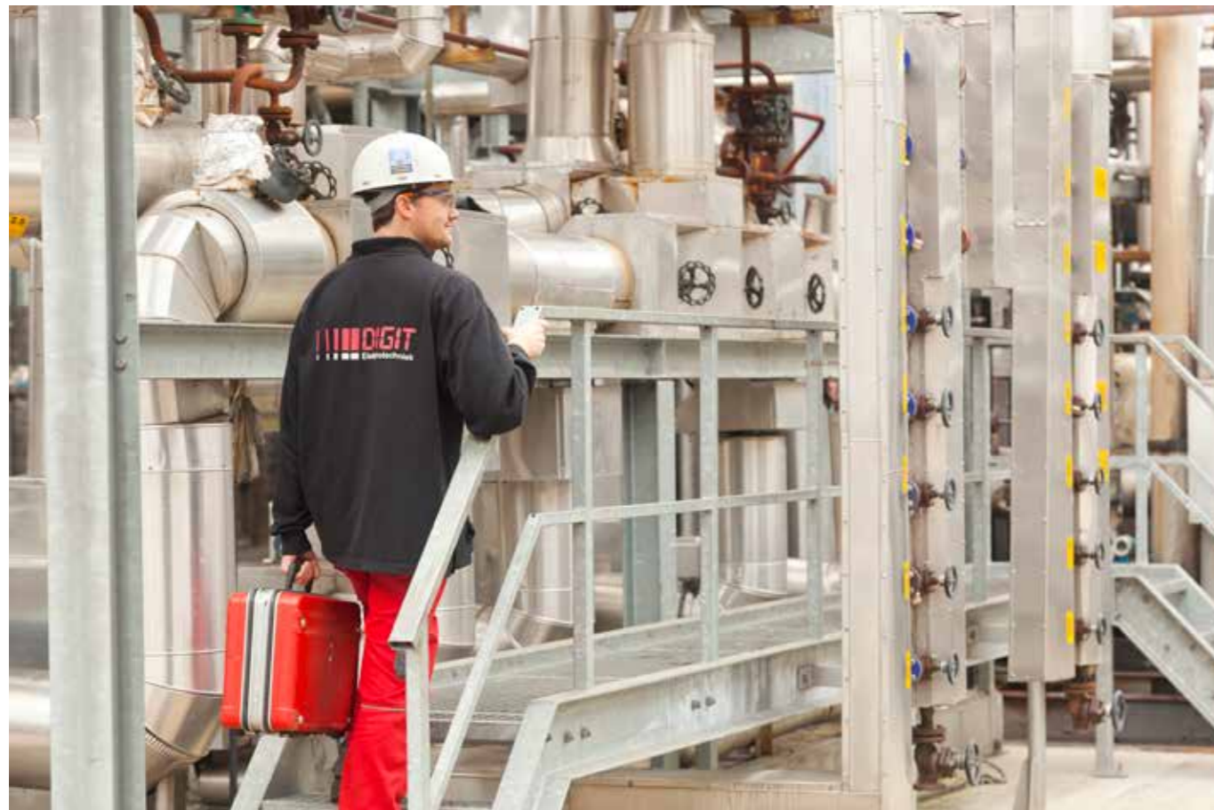
Onderhoudswerkzaamheden, uitgevoerd door DIGIT Elektrotechniek
