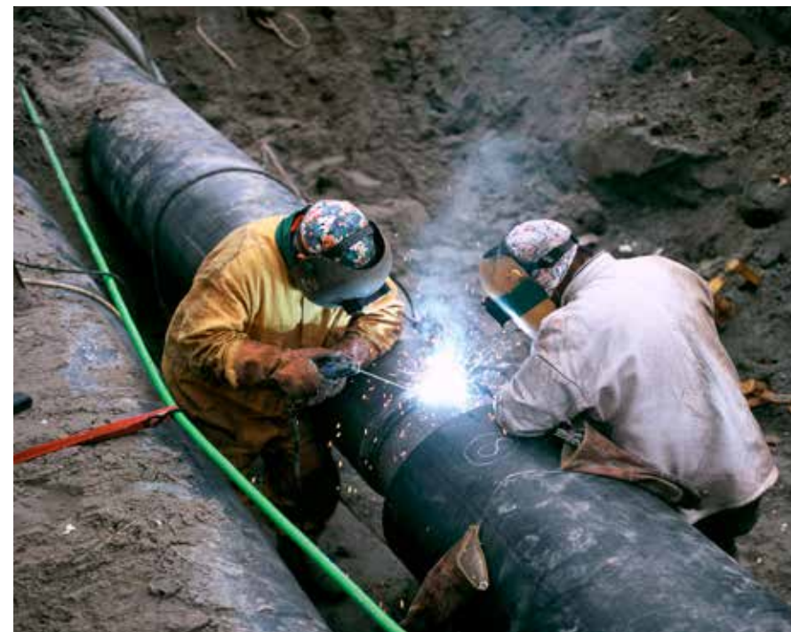
Lassen aan de stadsverwarming
