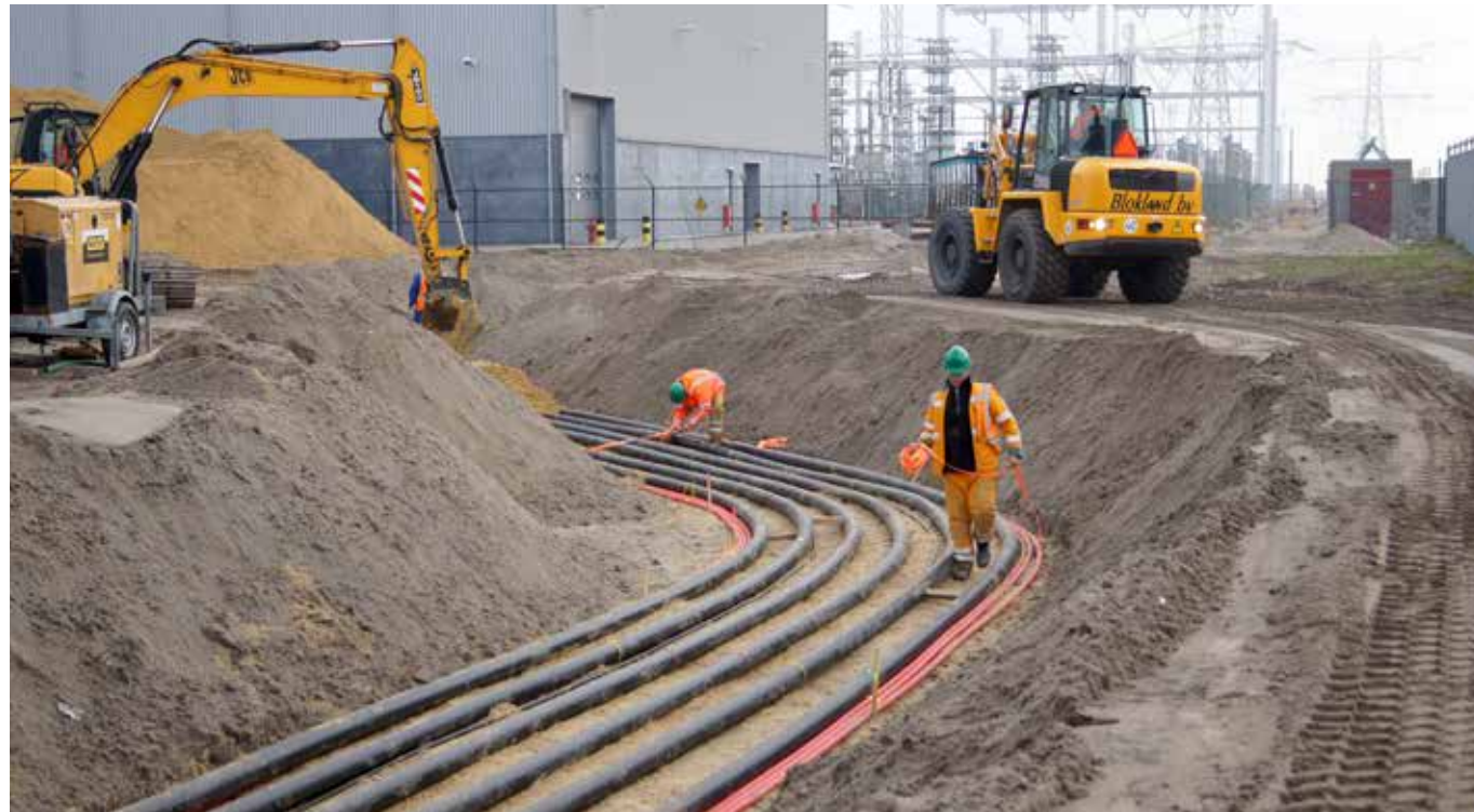
Kabels ondergronds - Maasvlakte
