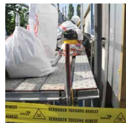
Asbestsanering Furkabaan Utrecht
