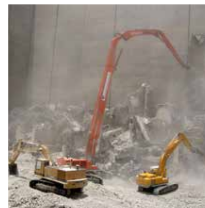
Slopen graansilo's Koeweit
