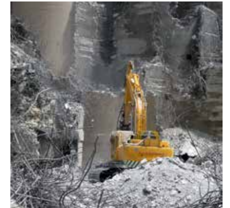
Slopen graansilo's Koeweit
